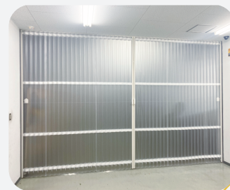
間仕切り工事
