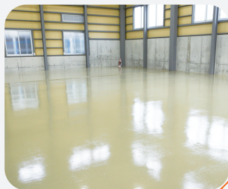
床防塵塗装工事
