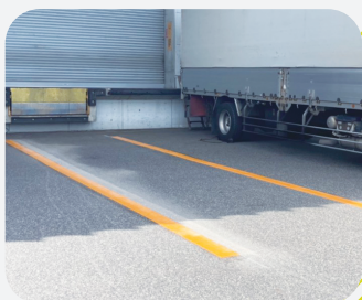
駐車場整備工事
