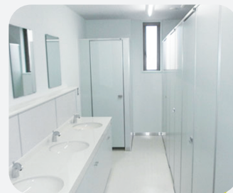
トイレ改装工事
