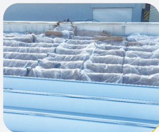
屋根断熱工事
